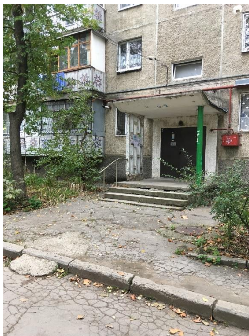
Reparația executată pe str. Teilor 11 (4,1 mii lei)
