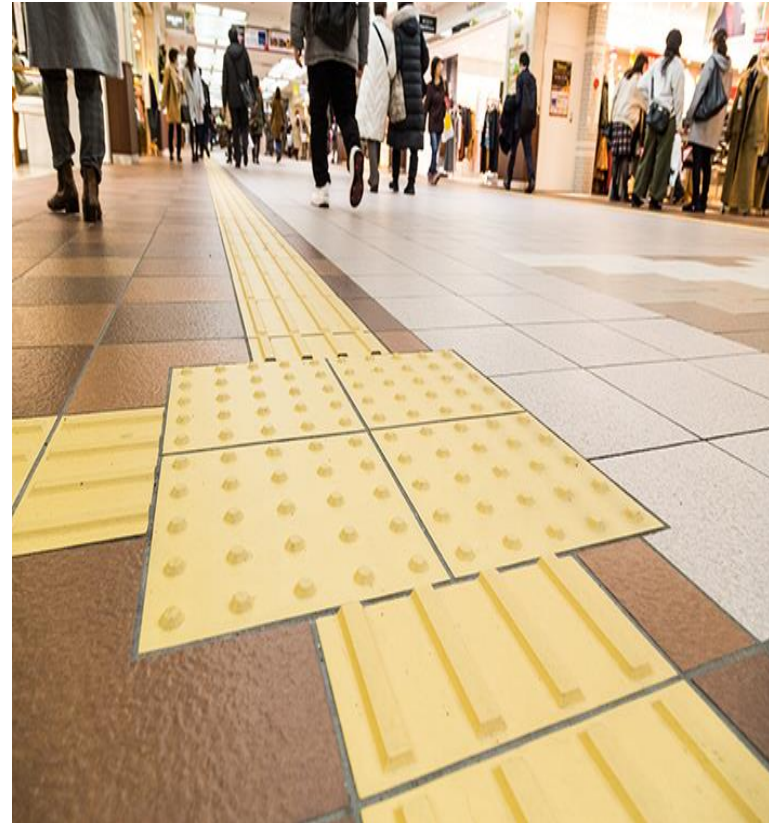
Foto 22. Model de instalare a pavajului de orientare și avertizare
