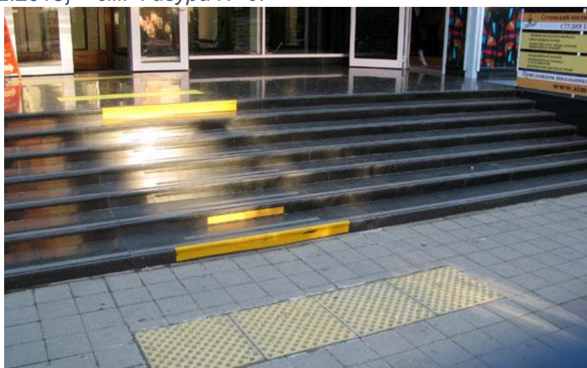
Фигура № 5: Пример установки предупреждающей тактильной плитки перед лестницей у входа в здание
