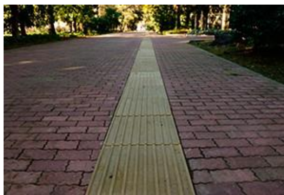
Фигура 1: Направляющая тактильная плитка (показывает направление движения)
