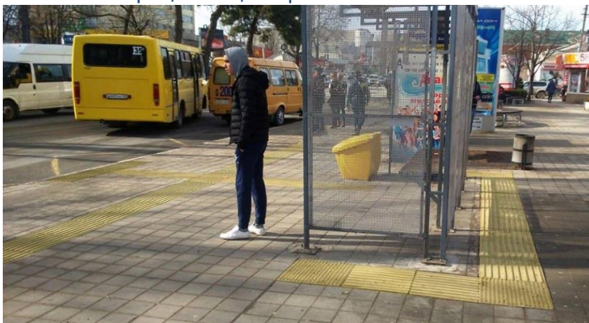
Фигура №4: Пример применения тактильного покрытия на остановках транспортных средств общего пользования
