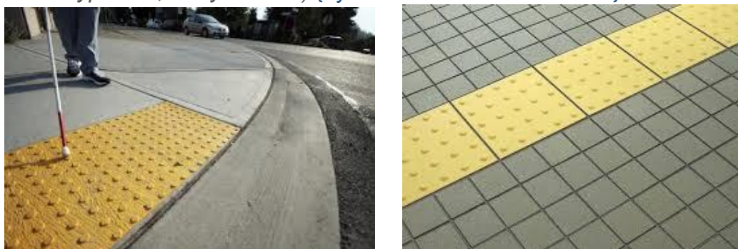
Фигура 2: Предупреждающая тактильная плитка (предупреждает о приближении к препятствиям, опасным участкам)
