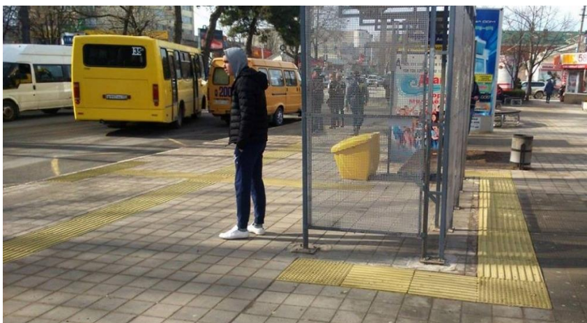
Figura 4: Exemplu de aplicare a pavajului tactil la stațiile de așteptare a transportului public în comun
