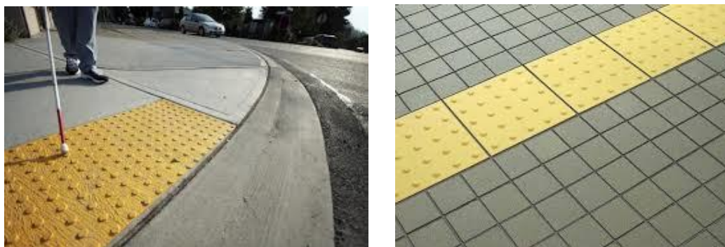
Figura 2: Pavajul tactil de avertizare (avertizează despre apropierea de obstacole și zone de pericol)
