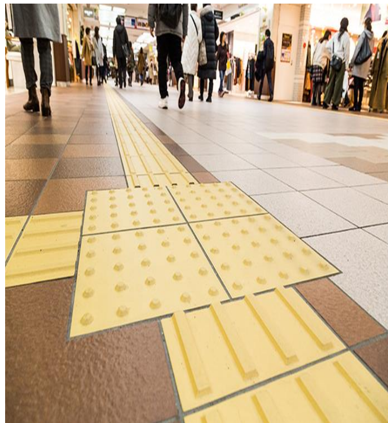
Foto 29. Model de instalare a pavajului de orientare și avertizare
