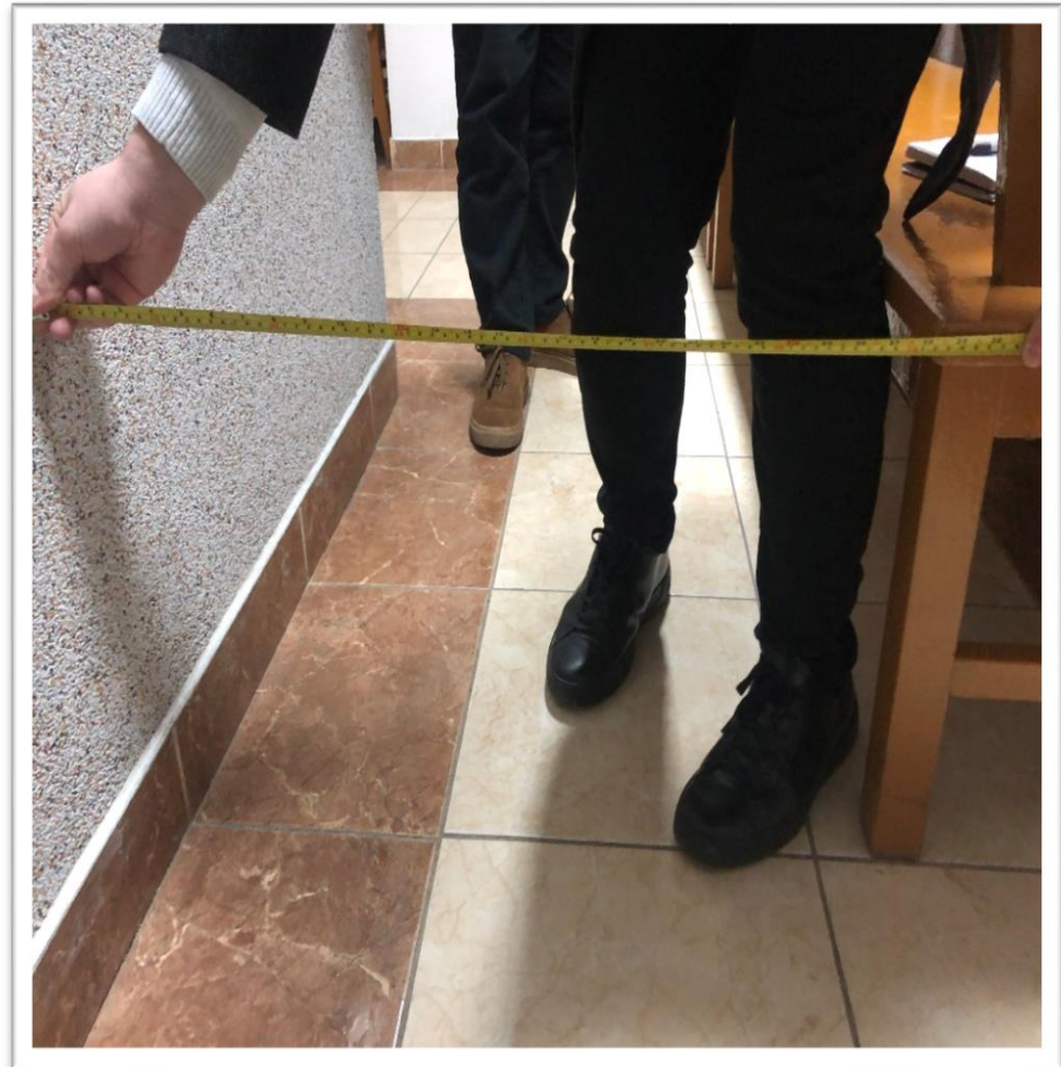
Foto 21 Spațiul insuficient de deplasare pe coridoare
